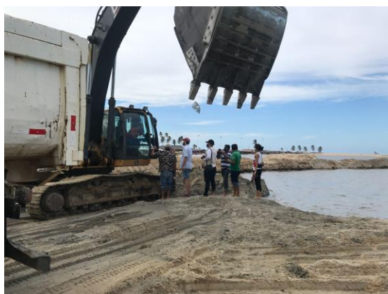
Figura 2: Imagem da escavação do leito do rio. Escavação 1.
