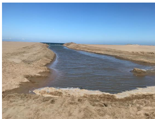
Figura 3: Imagem da escavação promovendo conexão artificialmente do rio com o mar. Escavação 2.
